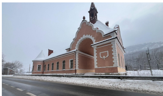
Obrázek 9: Nádraží budova „Karpaty” (dříve Beregvár) (Foto: autor)
