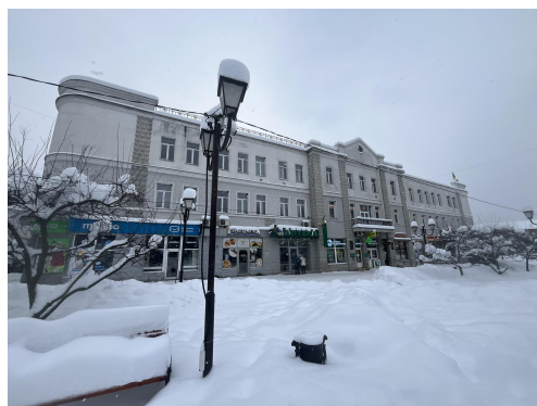
Obrázek 10: Celá budova bývalého hotelu Koruna v Chustu (zepředu) (Foto: autor)
